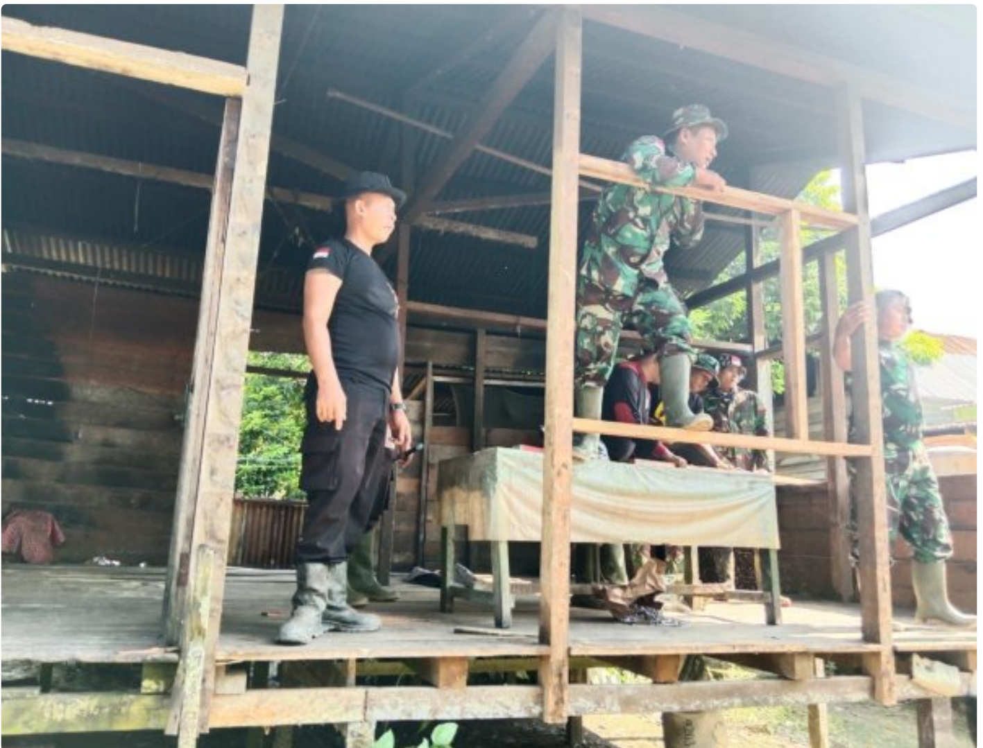
Terkejut Dan Syukur Ugkapan Bapak Charles Rumahnya Di Rehab Satgas TMMD Ke-118
