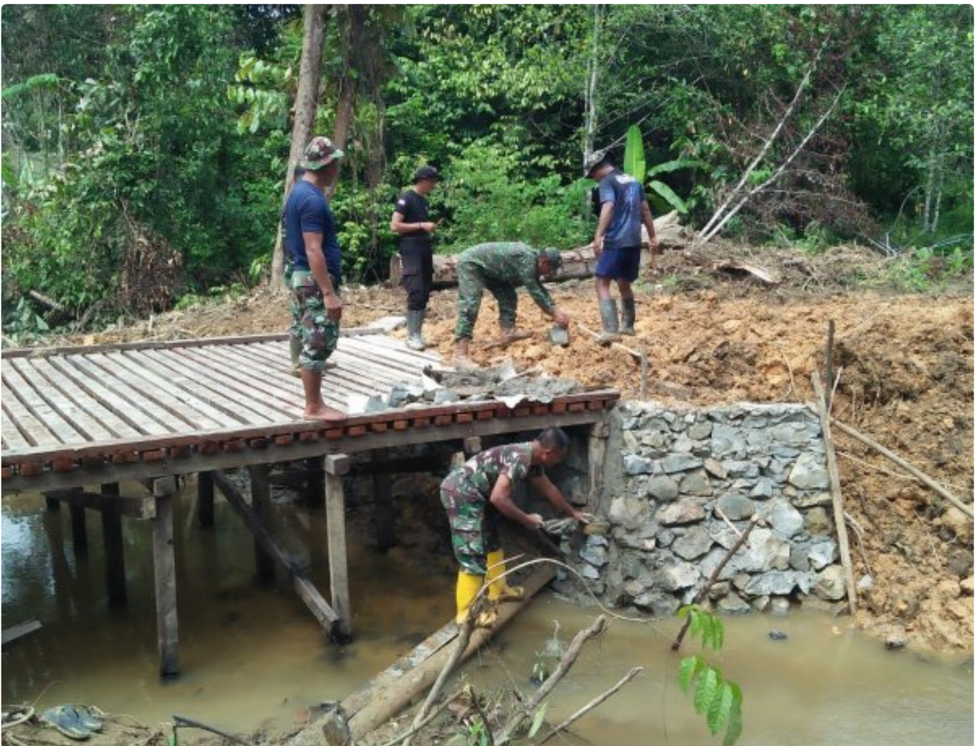
Progres Sasaran Jembatan Kayu Ulin TMMMD Ke- 118 Wiltas Kodim/Malinau Capai 75 Persen
